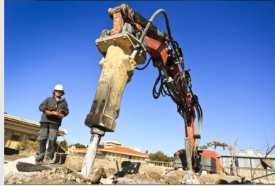
Brise roche sur un chantier de construction
